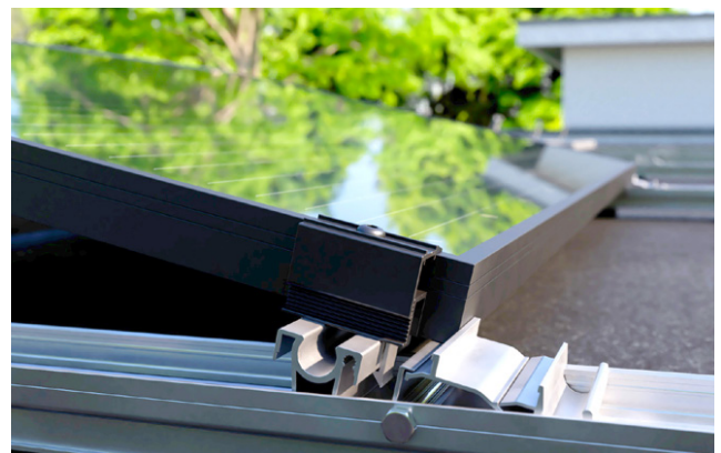
Ill. 13 - Endeklemmen sidder nu fast på panelet.
