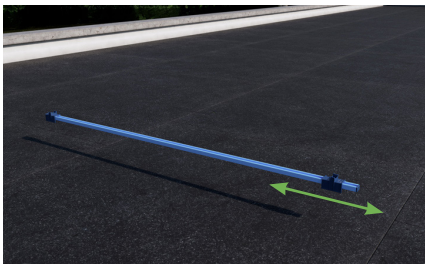
Ill. 2 - Konstruktionslægten bruges til at angive afstanden mellem profilerne ift. solpanelets dimensioner.
