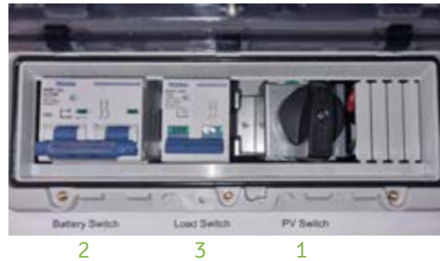
Ill. 6.3 - Afbrydere på KSTAR inverter.
